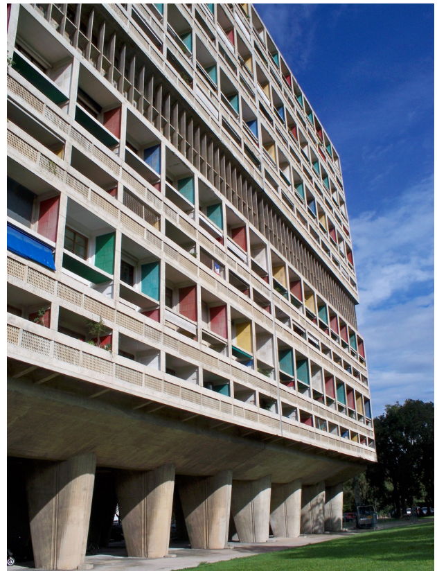
{ Unité d’habitation Le Corbusier (Marseille) courtesy of ADEUPa Brest , CCA-2.0 }
